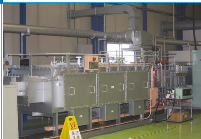
電気炉・プレスライン（銅製ヒートシンク製造）
