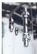
容器外洗用、天井設置ノズル
